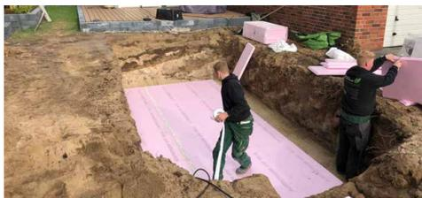
*Baugrube mit isolierter Bodenplatte*
